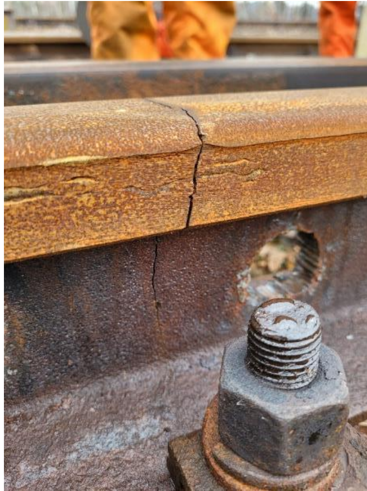
Fot.1 Widok pękniętej iglicy/szyny rozjazdu. Odcinek próbny nr 1.
